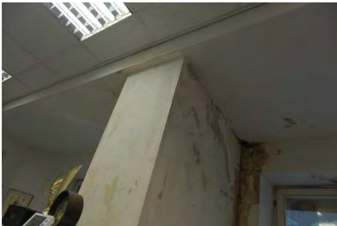
FF-20. Drėgmės pažeistos sienos patalpų viduje
