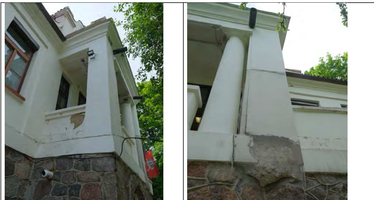
Šiaurės vakarų fasado akmenų mūro atraminė sienelė su kolonomis, laikančiomis balkoną, 2024m. Matomas stipriai drėgmės pažeistas paviršius, mūro netektys (sutvirtinta apsauginiu tinklu)
