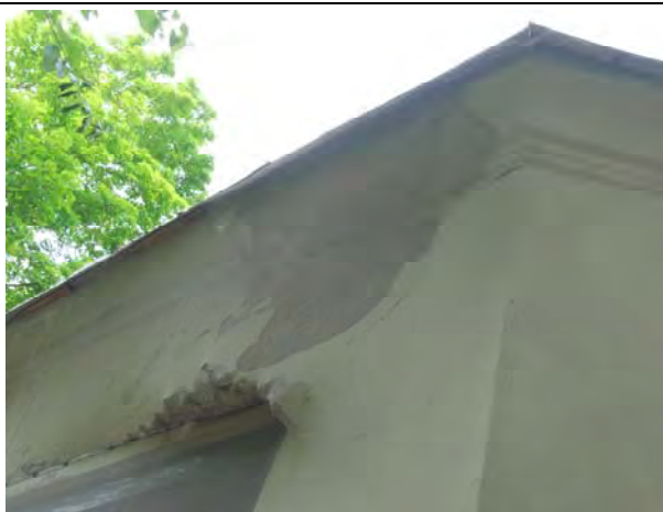
Pietryčių fasado fragmentas, 2024m. Matomas drėgmės pažeistas, atšokęs tinkas, mūro netektys įrengtas apsauginis tinkas (dėl galabais krentančio tinko)
