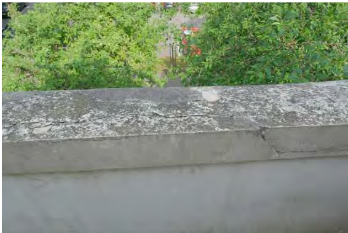
FF-23. ŠV balkono sutrūkinėjęs sienelės betoninis „porankis“
