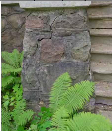
Atraminė sienelė šiaurės vakarų fasade, 2024m. Matomi dideli įtūkimai, drėgmės pažeistas tinkas, biologinėmis apnašomis užterštas paviršius
