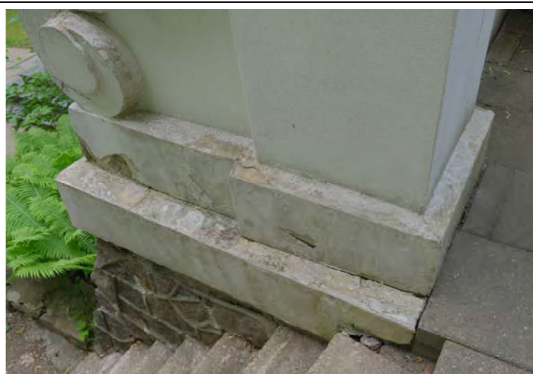
Atraminė sienelė šiaurės vakarų fasade, 2024m. Matomi dideli įtūkimai, drėgmės pažeistas tinkas, biologinėmis apnašomis užterštas paviršius
