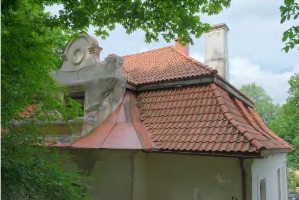
FF-28. Mansardinio stogo konstrukcija su „S“ tipo keraminių čerpių danga
