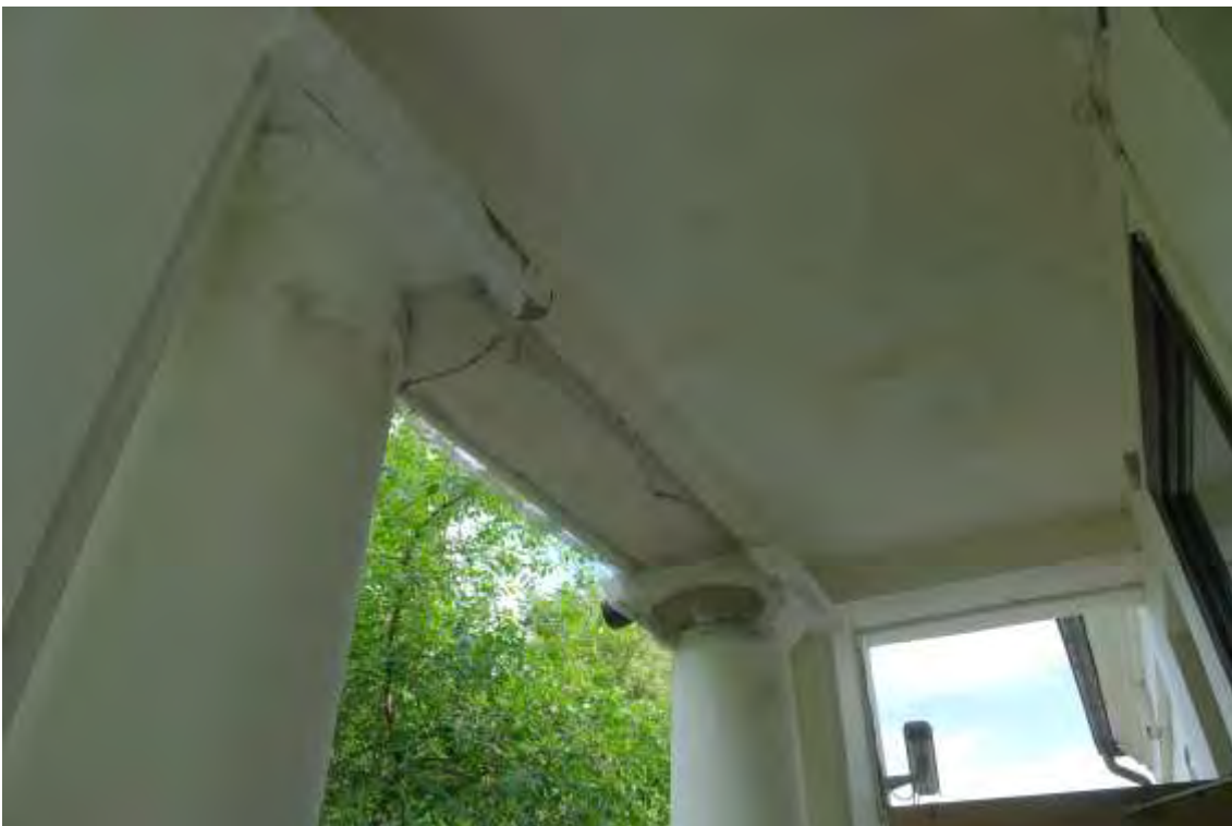
FF-9. Neigiamo atmosferos poveikio pažeistos portiko viršaus konstrukcijos
