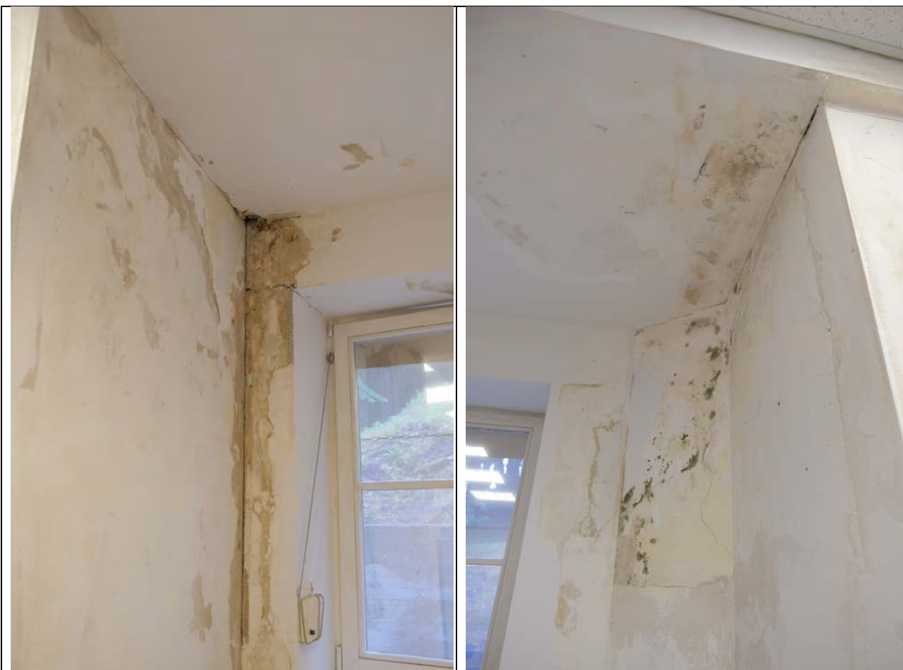
Pietryčių fasado siena iš vidaus, 2024m. Paviršius stipriai pažeistas drėgmės, vizualiai matomas pelėsis
