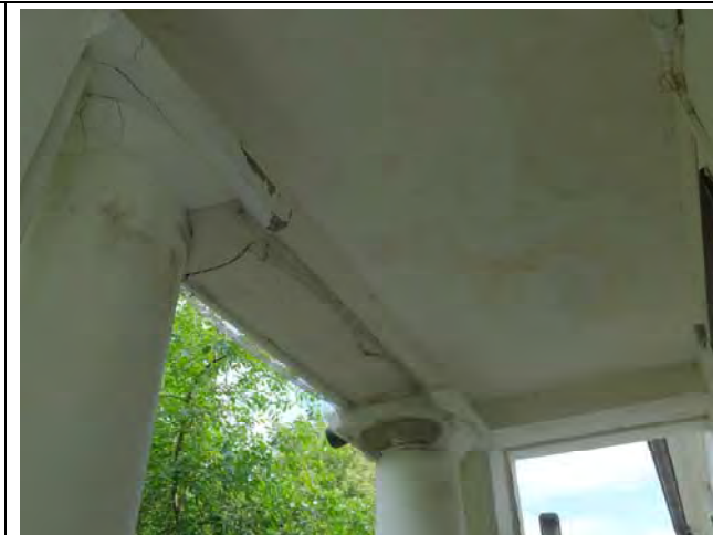
Šiaurės vakarų fasado laiptai su atramine sieniele ir kolonomis, laikančiomis balkoną, 2024m. Matomas stipriai drėgmės pažeistas ir biologinėmis apnašomis užterštas paviršius, įtrūkimai ir mūro netektys ties kolonų kapiteliais (sutvirtinta apsauginiu tinklu)
