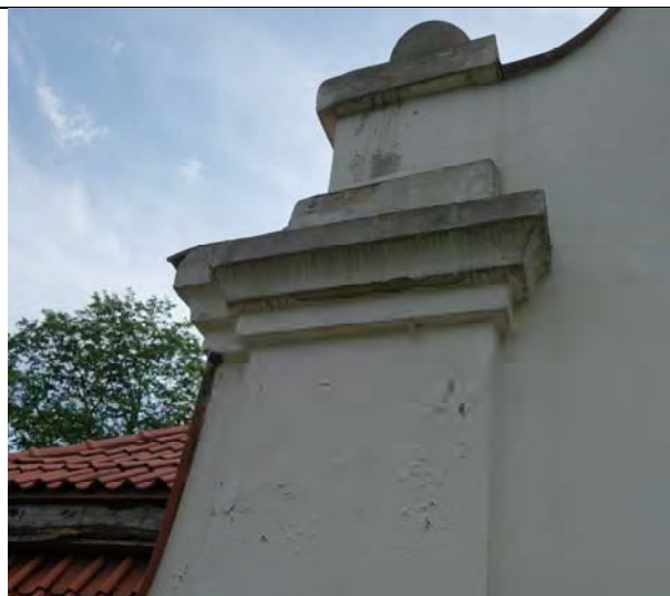
Šiaurės vakarų fasado frontono fragmentai, 2024m. Matomas drėgmės pažeistas paviršius, atšokęs tinkas, įtrūkimai ir mūro netektys
