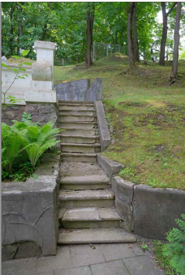
Betoniniai laiptai su atramine siennele šiaurės vakarų fasade, 2024m. Matomi dideli įtūkimai, ankstesnių remontų užtaisymai cementiniu skiediniu
