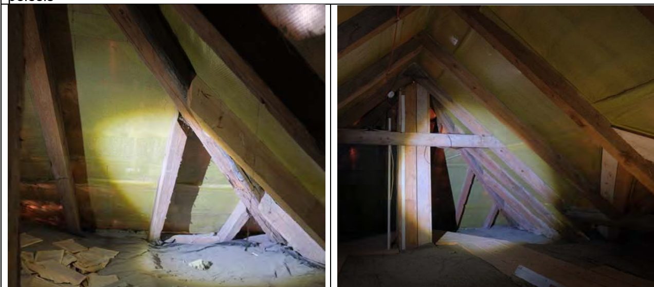
Medinės stogo konstrukcijos, 2024m. Konstrukcijų būklė- gera, pratekėjimų, drėgmės pažeidimų ar įlinkių- neužfiksuota, mediena- nesutrūnijusi
