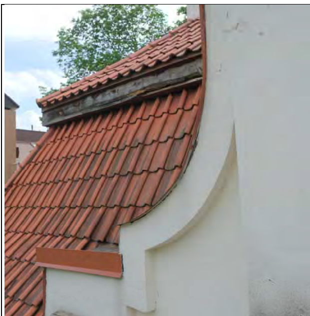
Šiaurės vakarų fasado frontono ir stogo fragmentai, 2024m. Matomas blogai įrengtas frontono apskardinimas (neužtikrina sandarumo), medinės valmo apaklimo lentos- sutrūnijusios
