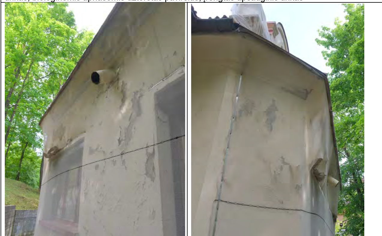
Pietryčių fasado fragmentas, 2024m. Matomas drėgmės pažeistas, atsilupęs tinkas, įrengtas apsauginis tinkas (dėl galabais krentančio tinko). Vidaus patalpose ši pastato dalis- stipriai pažeista palėsio
