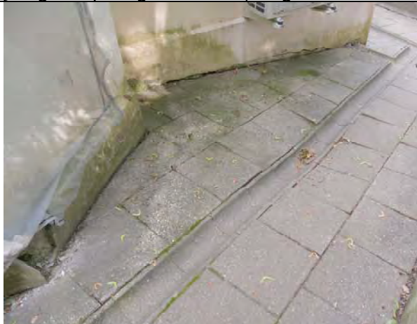
Šiaurės rytų fasado cokolinės dalies fragmentas, 2024m. Matomas drėgmės pažeistas, atšokęs tinkas, biologinėmis apnašomis užterštas paviršius
