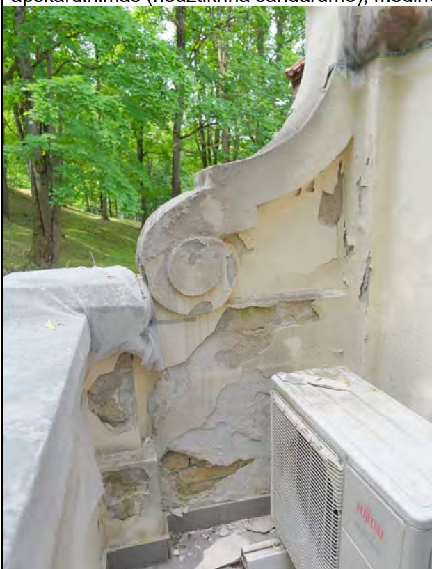
Pietryčių fasado frontono ir balkono tvorelės fragmentai, 2024m. Matomas labai stipriai drėgmės pažeistas, atšokęs tinkas, mūro netektys, įrengtas apsauginis tinkas (dėl galabais krentančio tinko)
