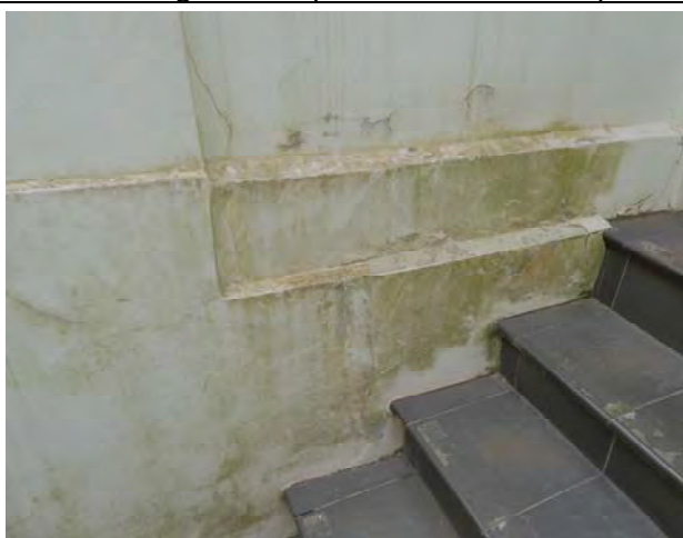
Šiaurės vakarų fasado laiptai su atramine sieniele ir kolonomis, laikančiomis balkoną, 2024m. Matomas stipriai drėgmės pažeistas ir biologinėmis apnašomis užterštas paviršius, įtrūkimai ir mūro netektys ties kolonų kapiteliais (sutvirtinta apsauginiu tinklu)
