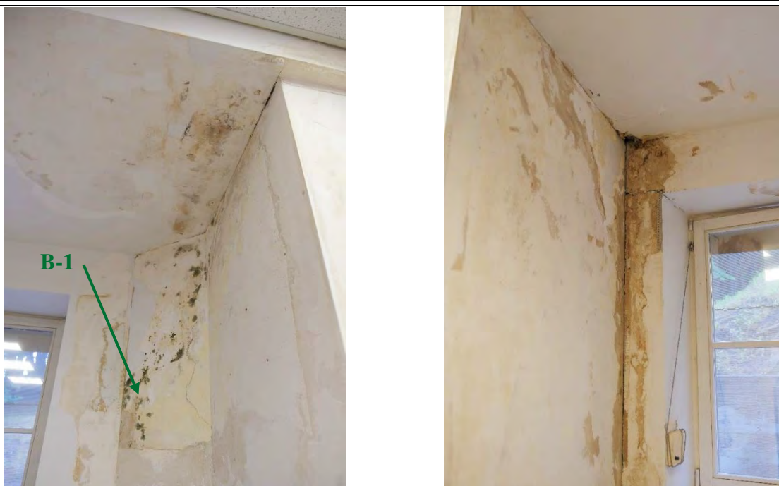
5 pav. Mikromicetais užterštų patalpų paviršių bendras vaizdas: A – pažymėta mėginio paėmimo vieta; B – sienų pažeidimai – bendras vaizdas.
