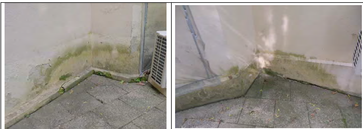
Pietryčių fasado cokolinės dalies fragmentas, 2024m. Matomas drėgmės pažeistas, atšokęs tinkas, biologinėmis apnašomis užterštas paviršius, įrengtas apsauginis tinkas
