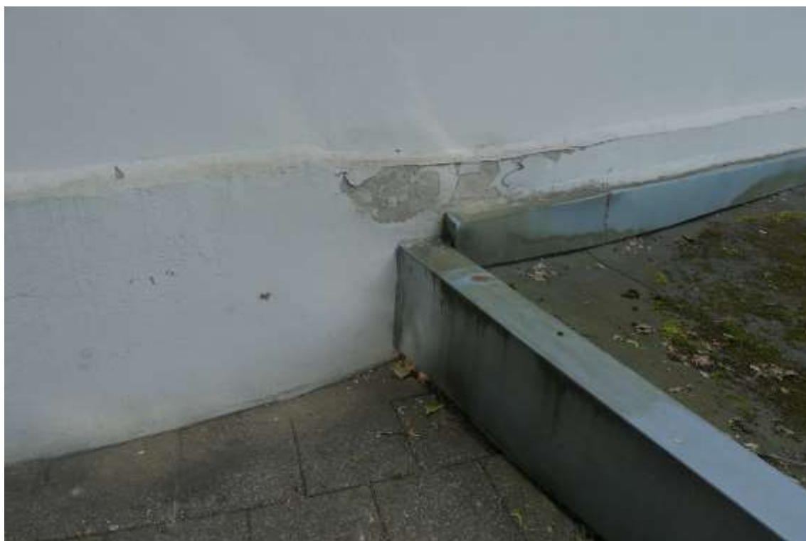
FF-7. Drėgmės pažeistas tinkas pastato R pusėje
