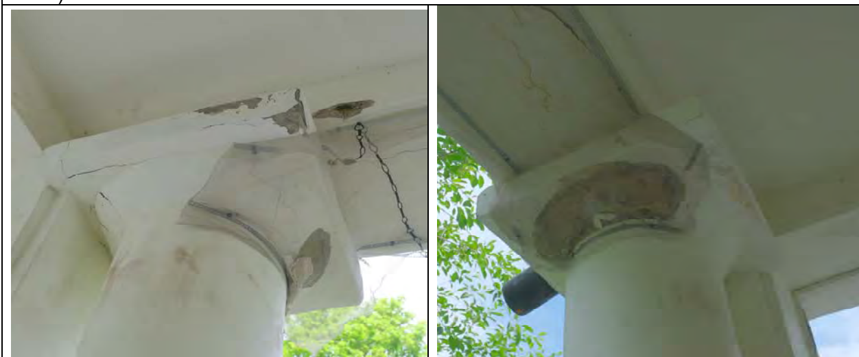
Šiaurės vakarų fasado kolonos, laikančios balkoną, 2024m. Matomas drėgmės pažeistas paviršius, įtrūkimai ir mūro netektys ties kolonų kapiteliais (sutvirtinta apsauginiu tinklu)
