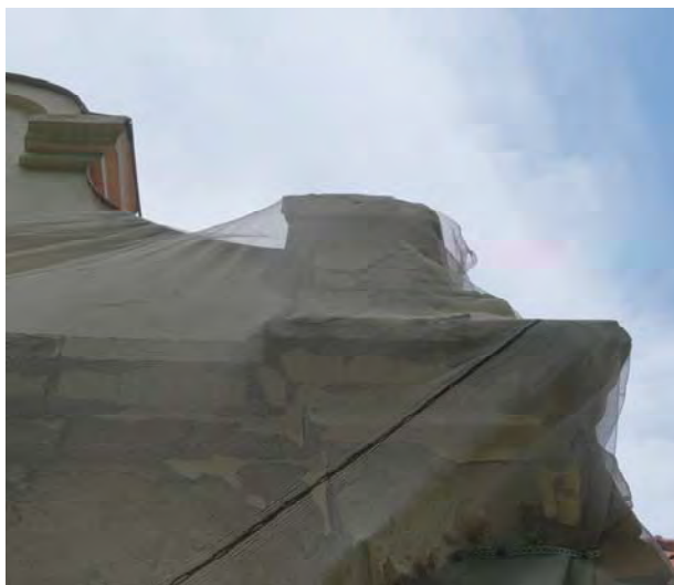
Pietryčių fasado frontono ir stogo fragmentai, 2024m. Matomas labai stipriai drėgmės pažeistas, atšokęs tinkas, mūro netektys, įrengtas apsauginis tinkas (dėl galabais krentančio tinko), medinės valmo apaklimo lentos- sutrūnijusios
