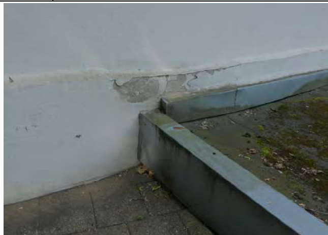
Šiaurės rytų fasado cokolinės dalies fragmentas, 2024m. Matomas drėgmės pažeistas, atšokęs tinkas, biologinėmis apnašomis užterštas paviršius
