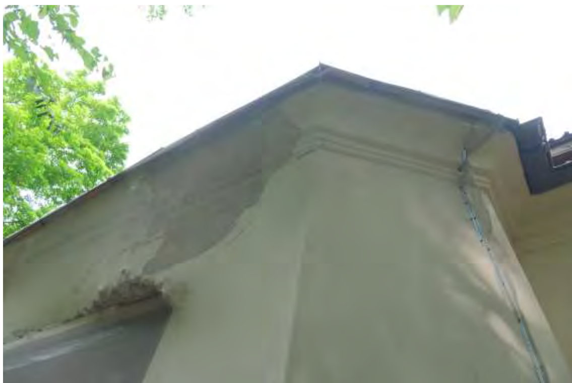
FF-16. Sienų pažeidimai pastato PR pusėje, po balkonu
