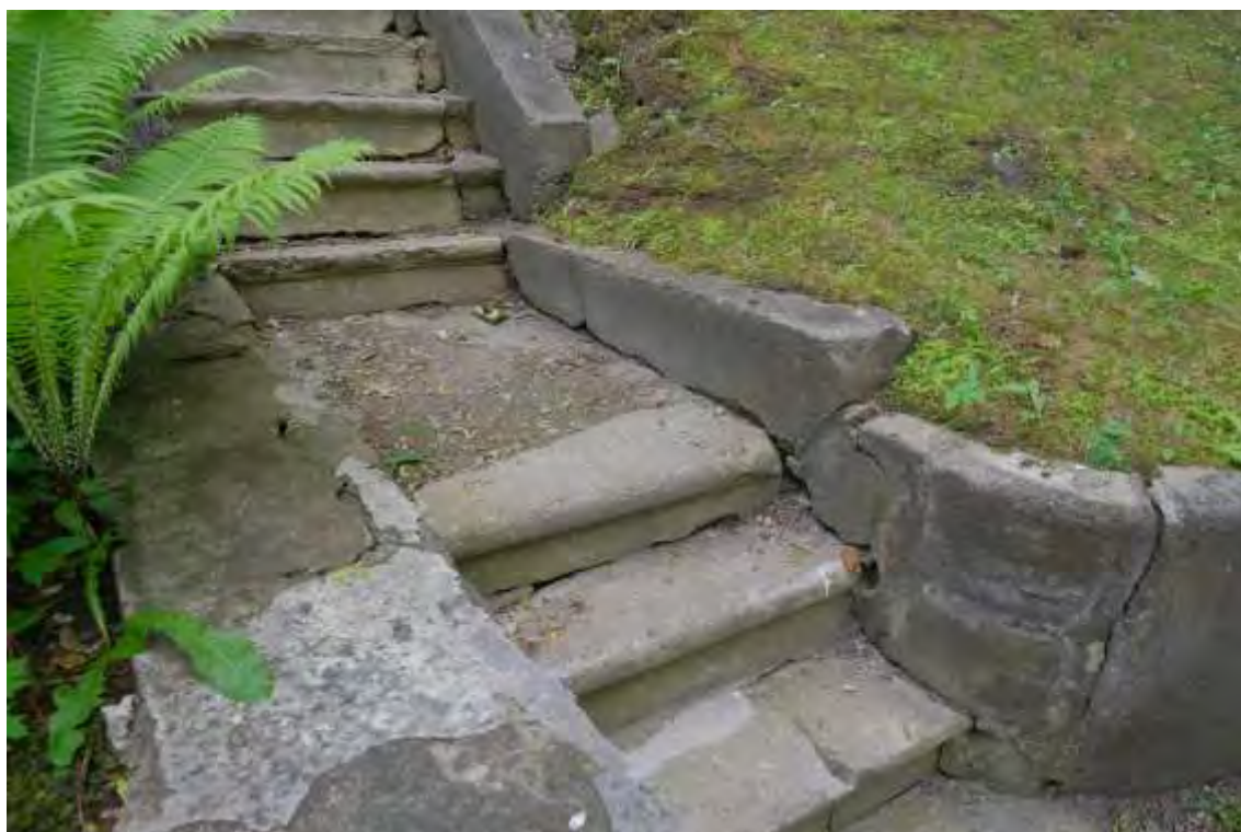
FF-36. Atraminė betono siena daugelyje vietų suskilusi, deformuota grunto poveikio. Betoniniai laiptai sutrūkinėję, tarp pakopų atsivėrę dideli plyšiai
