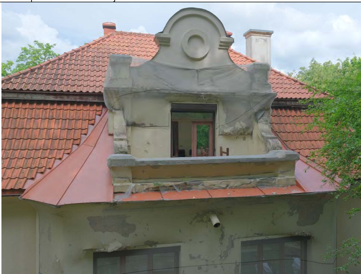
Pietryčių fasado fragmentas, 2024m. Matomas labai stipriai drėgmės pažeistas, atšokęs tinkas, mūro netektys, įrengtas apsauginis tinkas (dėl galabais krentančio tinko)
