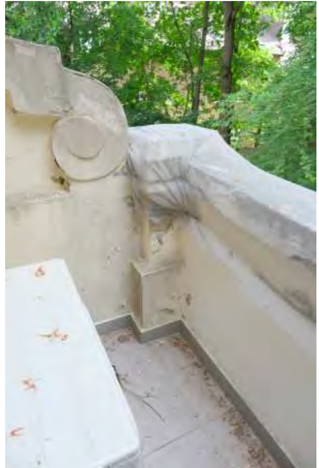
FF-26. PR balkono pažeidimai iš dešinės
