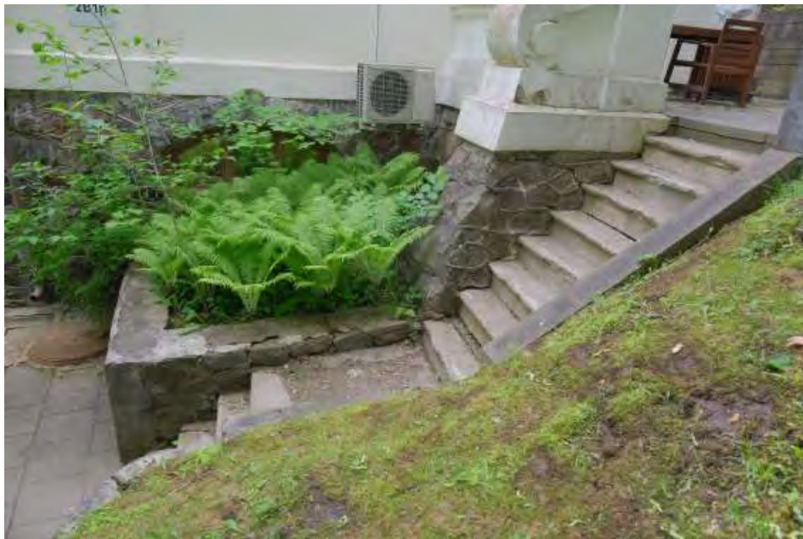
FF-34. Akmenų mūro atraminės sienos viršaus cementinio sk. padengimas sutrūkinėjęs, nubyrėjęs. Sieną ne kartą buvo remontuota
