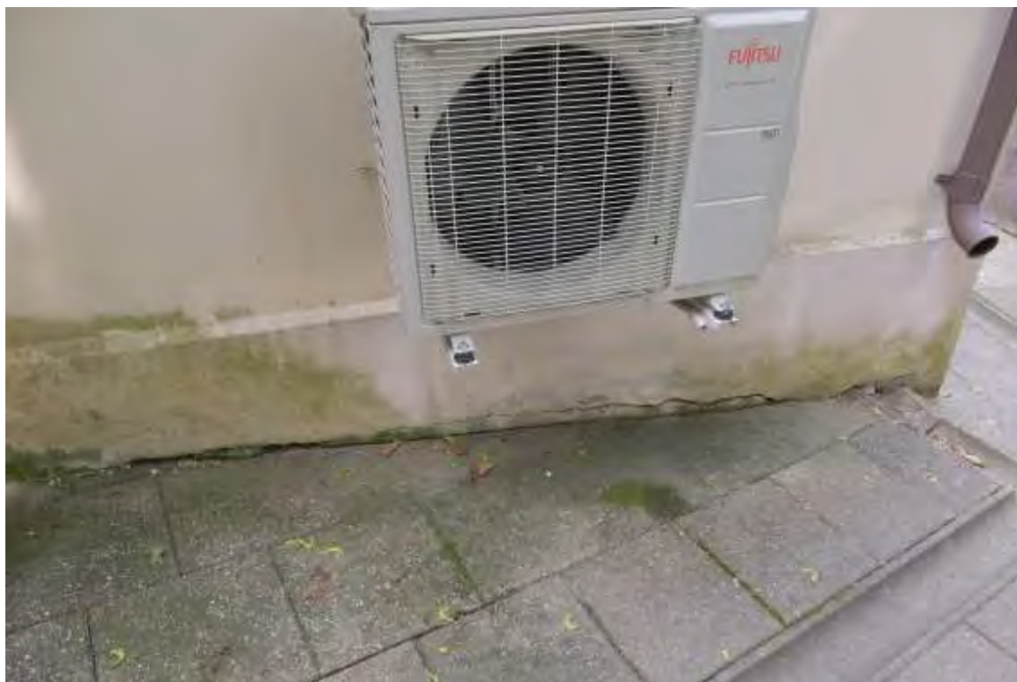
FF-6. Sienos ir cokolio pažeidimai pastato PR pusėje
