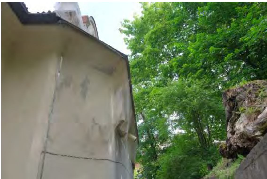
FF-15. Sienų pažeidimai pastato PR pusėje, po balkonu
