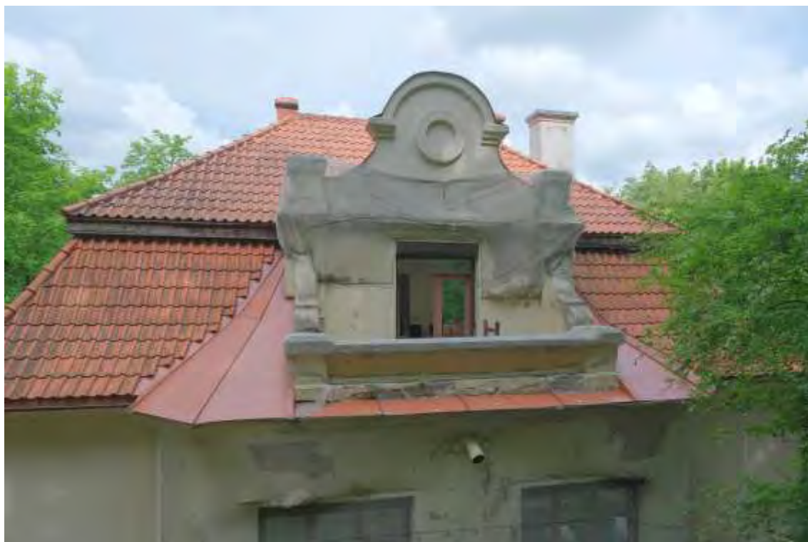
FF-17. PR pusėje esančio pažeisto dekoratyvaus frontono bendras vaizdas
