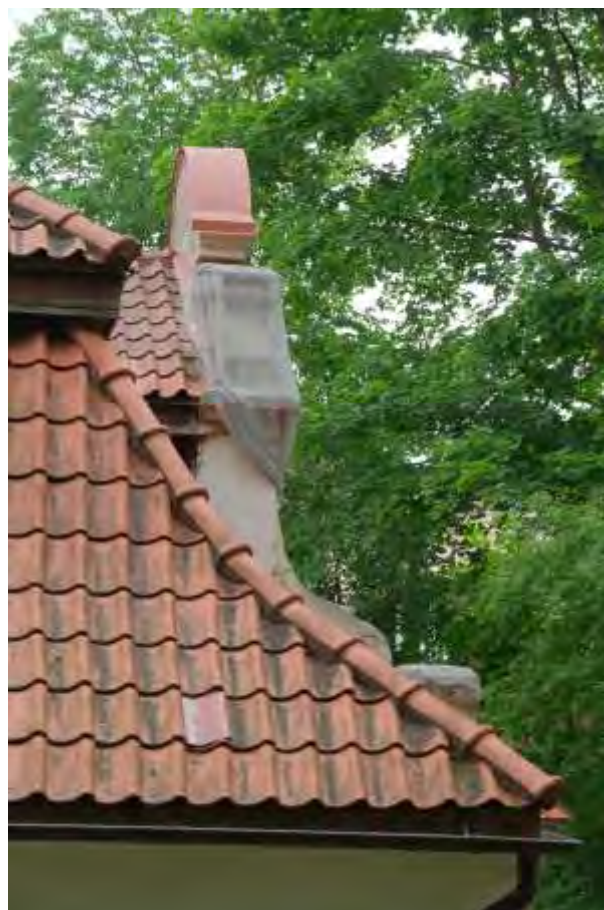
FF-31. Pažeistās ir vandenī praleidziantis PR pusēs stogo apskardīnīmās ties frononu. Matoma remontuota čerpē skardos lankstīni
