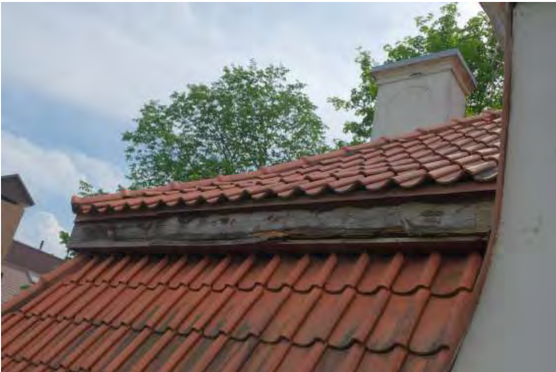
FF-29. Šioje vietoje esančios medinės vėjalentės yra pažeistos visu pastato perimetru
