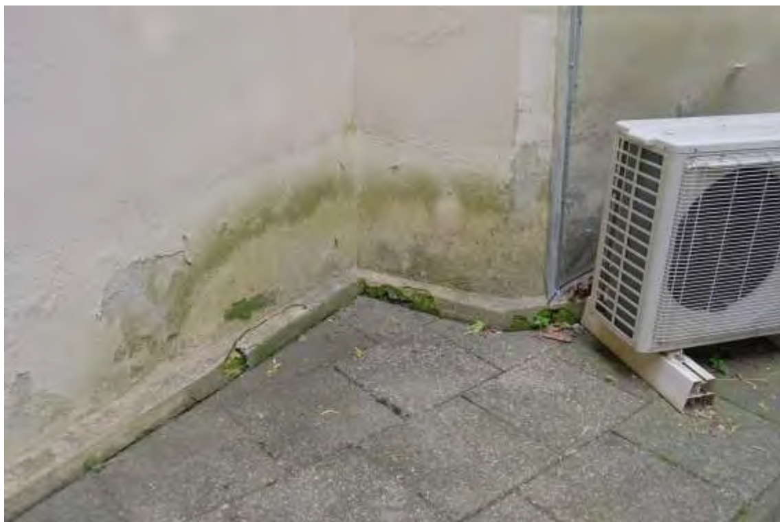
FF-4. Sienos ir cokolio pažeidimai pastato PR pusėje
