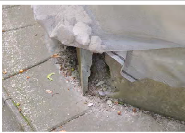
Pietryčių fasado fragmentas, 2024m. Matomas drėgmės pažeistas, atšokęs tinkas, mūro netektys įrengtas apsauginis tinkas (dėl galabais krentančio tinko)
