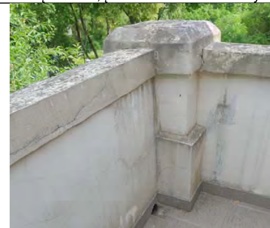
Šiaurės vakarų fasado balkono tvorelės fragmentai, 2024m. Matomas drėgmės ir biologinėmis apnašomis užterštas paviršius, įtrūkimai ir mūro netektys
