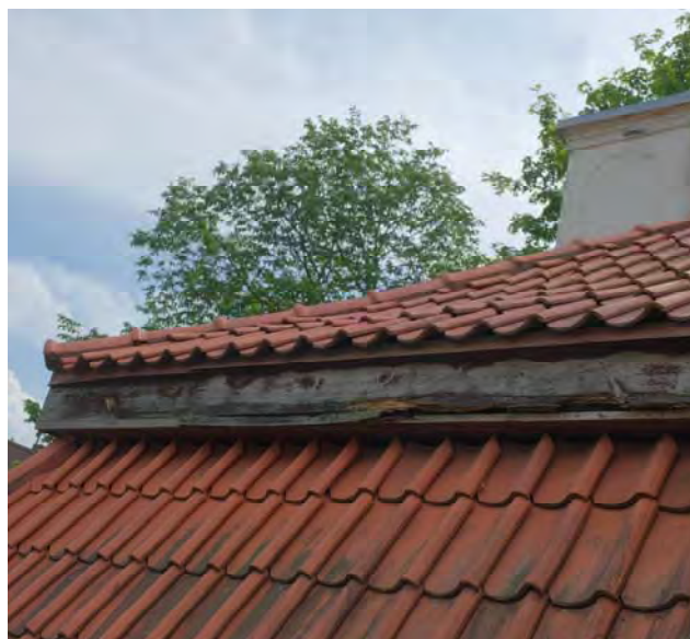
Šiaurės vakarų fasado frontono ir stogo fragmentai, 2024m. Matomas blogai įrengtas frontono apskardinimas (neužtikrina sandarumo), medinės valmo apaklimo lentos- sutrūnijusios
