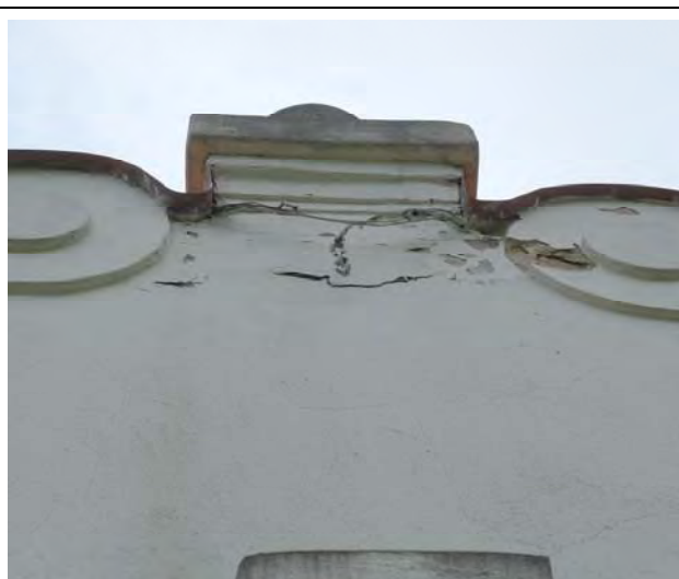
Šiaurės vakarų fasado frontono fragmentai, 2024m. Matomas drėgmės pažeistas paviršius, atšokęs tinkas, įtrūkimai ir mūro netektys
