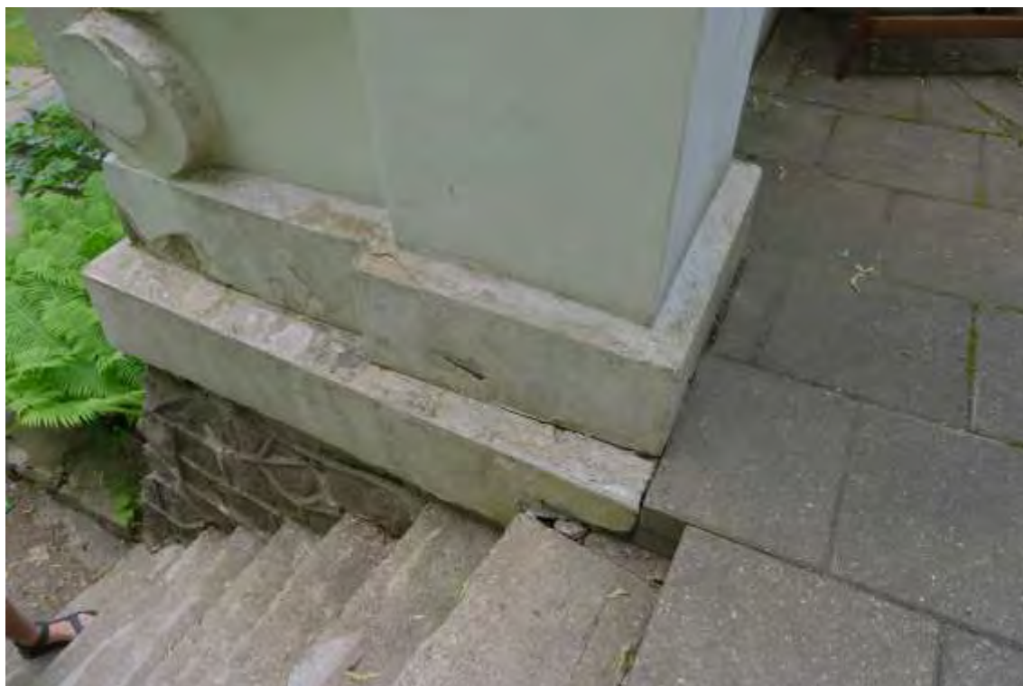
FF-37. Ties apačia sutrūkinējšs dekoratīvinis sienelēs elements
