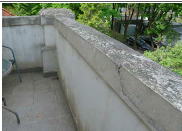
Šiaurės vakarų fasado balkono tvorelės fragmentai, 2024m. Matomas drėgmės ir biologinėmis apnašomis užterštas paviršius, įtrūkimai ir mūro netektys
