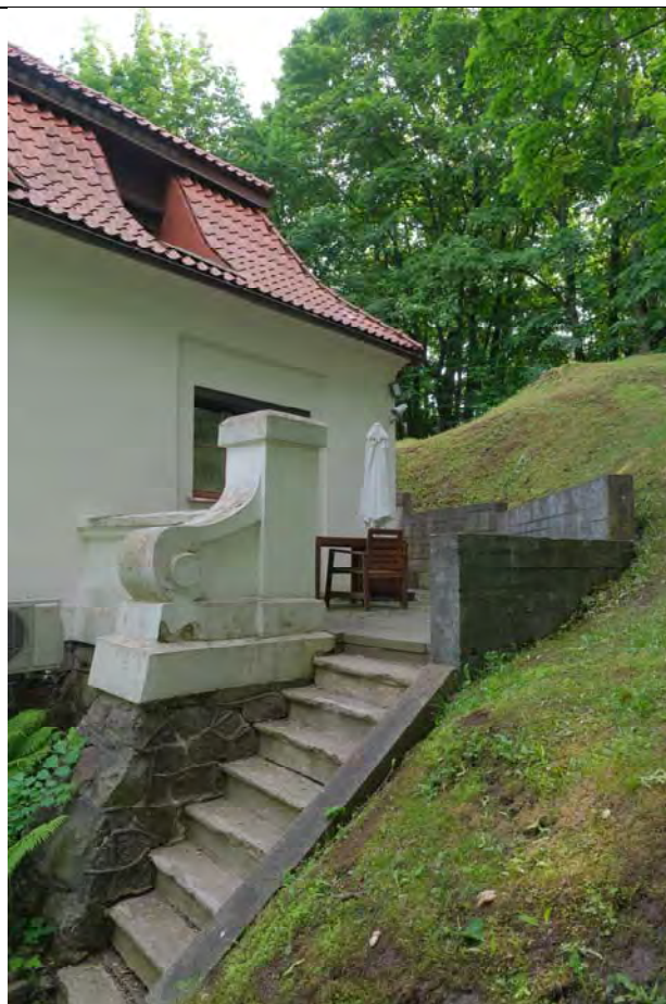
Betoniniai laiptai su atramine siennele šiaurės vakarų fasade, 2024m. Matomi dideli įtūkimai, ankstesnių remontų užtaisymai cementiniu skiediniu
