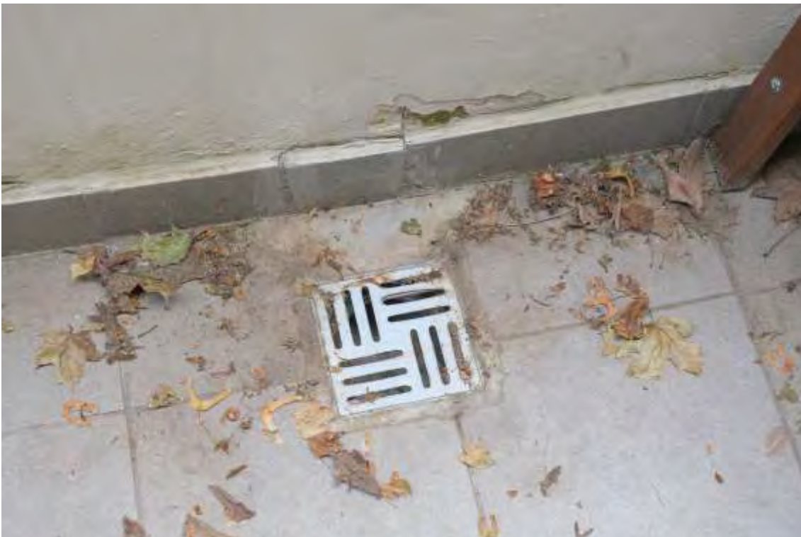
FF-27. PR balkono vandens nuvedimo trapas
