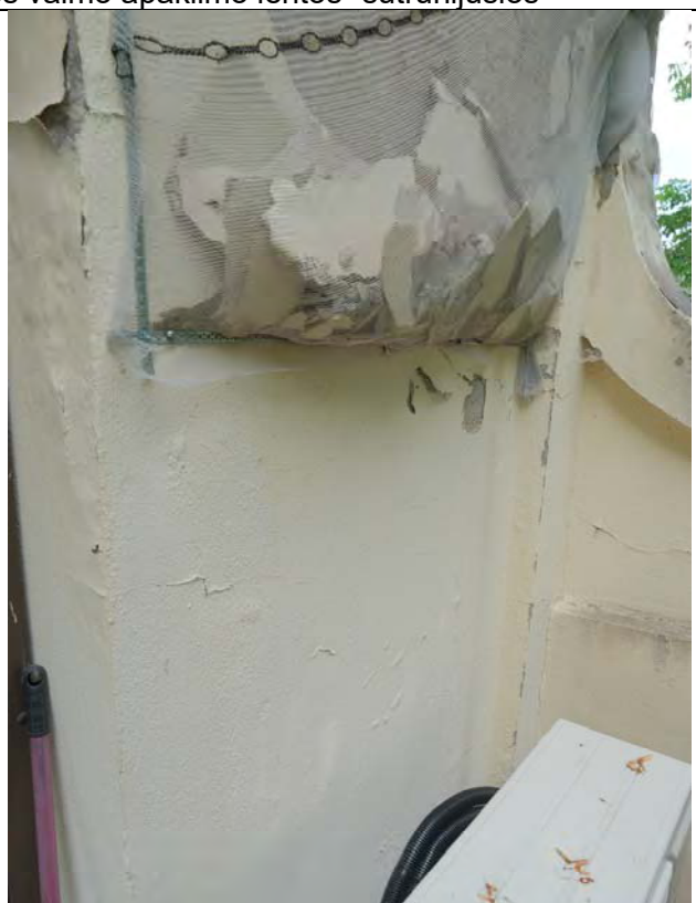
Pietryčių fasado frontono ir balkono tvorelės fragmentai, 2024m. Matomas labai stipriai drėgmės pažeistas, atšokęs tinkas, mūro netektys, įrengtas apsauginis tinkas (dėl galabais krentančio tinko)
