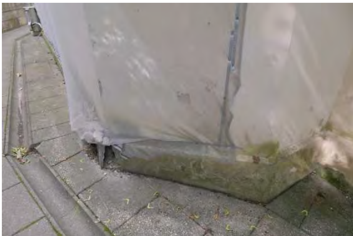
FF-5. Sienos ir cokolio pažeidimai pastato PR pusėje
